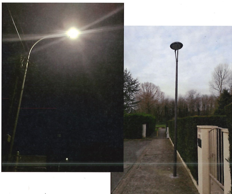
Début du remplacement de tout l'éclairage public en LED
