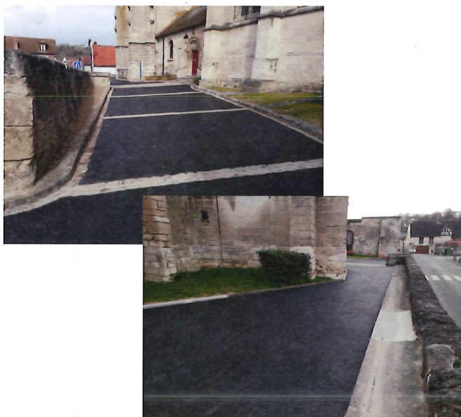
Réfection du parvis de l'église
