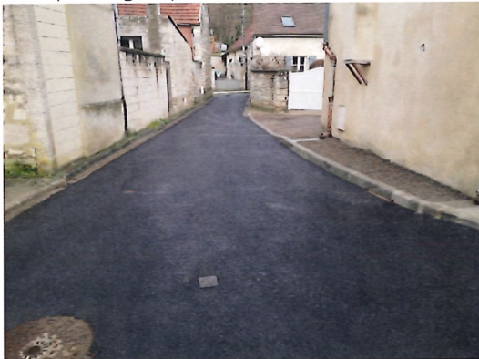
Réfection de la voirie de l'entrée du parking Impasse Lefèvre Lesueur
