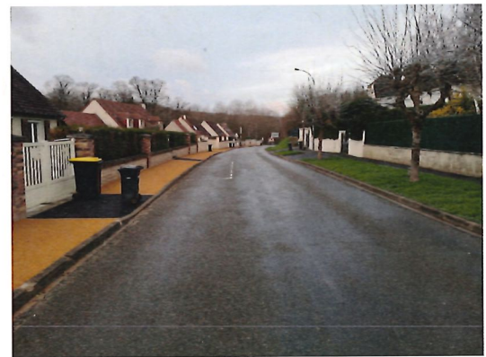
Aménagement des trottoirs rue Pasteur
